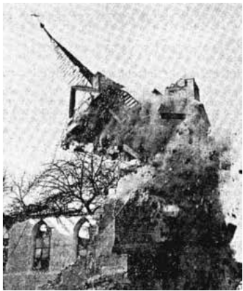
Mit einem Drahtseil wird der Turm der Wombacher Kirche umgerissen.
